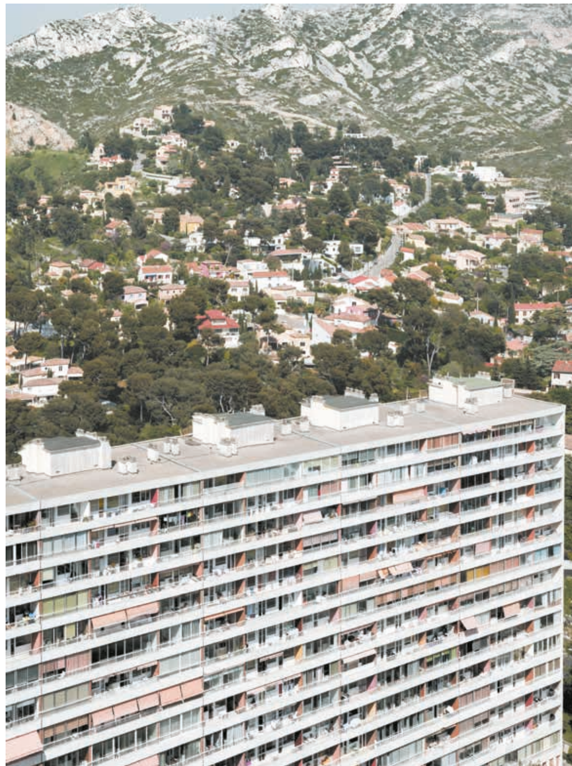
Philippe Chancel, Quartiers Nord et quartiers Sud , 2017-2018, 2019. © Adagp, Paris, 2021. Collection Frac Provence-Alpes-Côte d'Azur.
